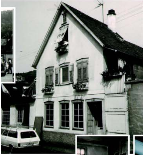
Das Werkstatt- und Wohngebäude im Neuenburger Unterwässerweg
